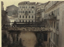
(Από τη φωτιά στην περιοχή του Καμυλίου το 1986)
