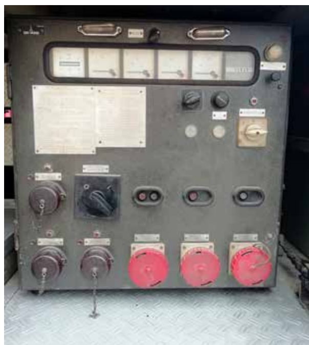
Πλάγια όψη που αποκαλύπτει λεπτομέρειες της ηλεκτρογεννήτριας παραγωγής ρεύματος ισχύος 20KVA. Στις κόκκινες πρίζες των 380V κομψώνεται πενταπολικός ακροδέκτης με καλώδιο για τη χρήση του απαγωγέα ή της αντλίας καυσίμου. Αριστερά διακρίνονται τα 3 σούκο 220V για τη χρήση λοιπών εργαλείων
