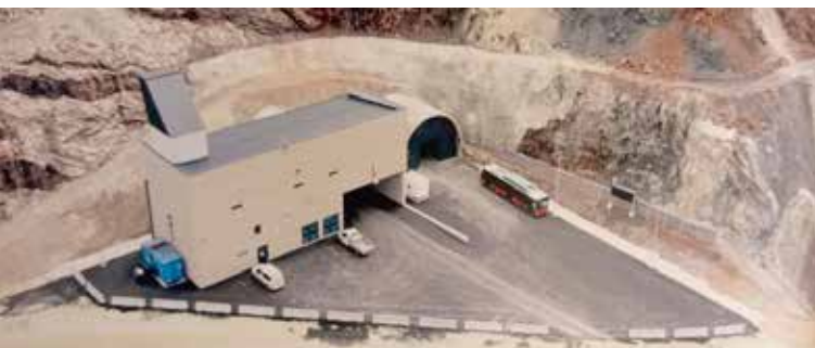
Η είσοδος στο κέντρο εκπαίδευσης πυρκαγιών σε τούνελ. Photo Dr. Galler, ZaB-Zentrum am Berg, Montanuniversität Leoben, Austria
