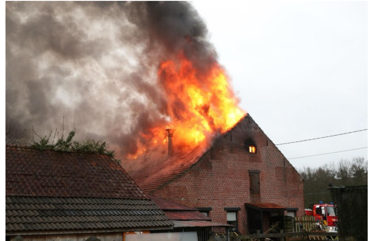
Εικόνα 2. Φωτιά σε σπίτι. Η φωτιά μαίνεται στην οροφή. Ξύλινα δοκάρια συνδέουν το αέτωμα με άλλα μέρη του κτιρίου. Καθώς περνά ο χρόνος, αυτές οι δοκοί θα καούν και το αέτωμα μπορεί να πέσει προς την εξωτερική κατεύθυνση. (Εικόνα: Frank Boelens)
